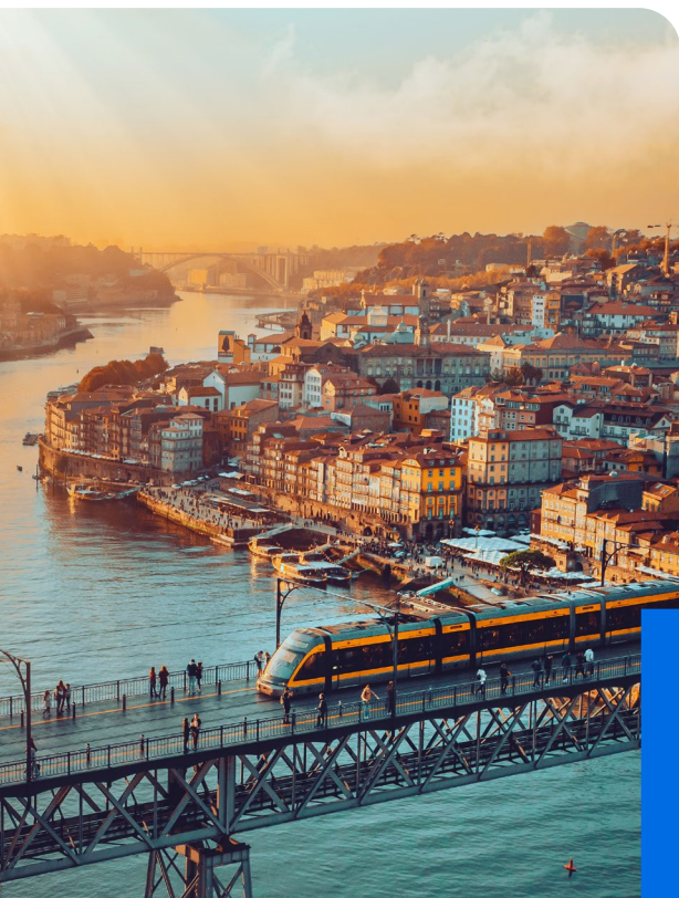
Ponte D. Luís I sobre o Douro, no Porto
